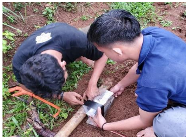
Gambar 8. Pemasangan MOV pada pipa
