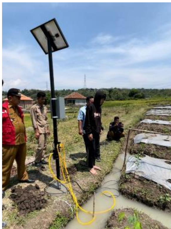
Gambar 5. Pemasangan Teknologi PETIS Berbasis Solar Panel di Lokasi Mitra
